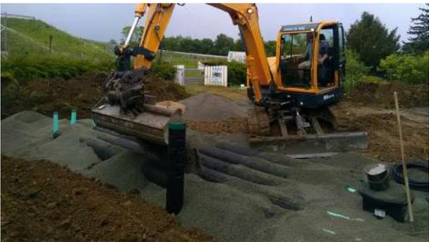
Calage des conduites et remblais avec 10 cm de sable filtrant au-dessus des conduites.
