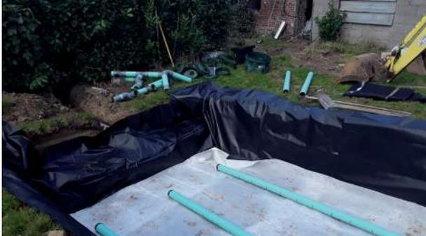
Pose des géotextiles de protection, de la membrane et de la collerette d'étanchéité.
