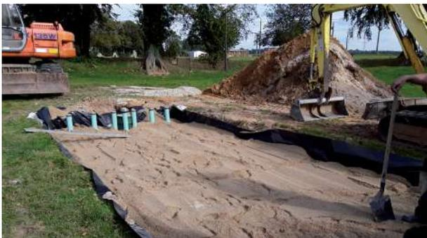
Calage des conduites et remblais avec 10 cm de sable filtrant au-dessus des conduites.
