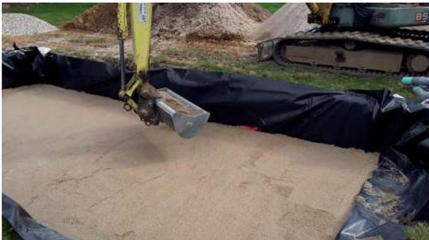
Pose du sable filtrant sur 30 cm réglé de niveau.
