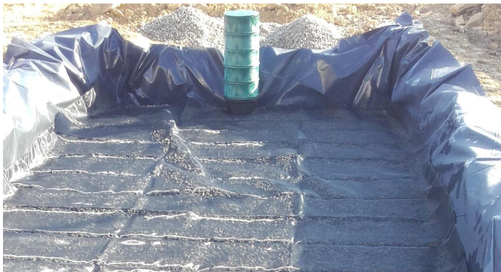
Figure 29– Mise en place de la grille de séparation
