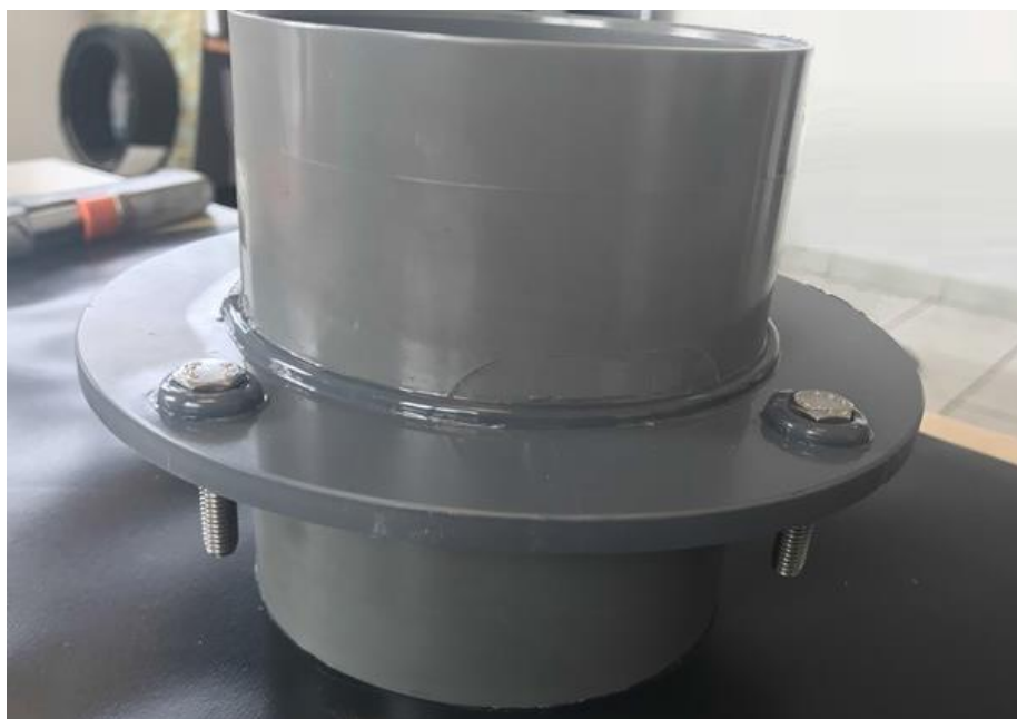
Figure 24 – Mise en place de la collerette étanche
